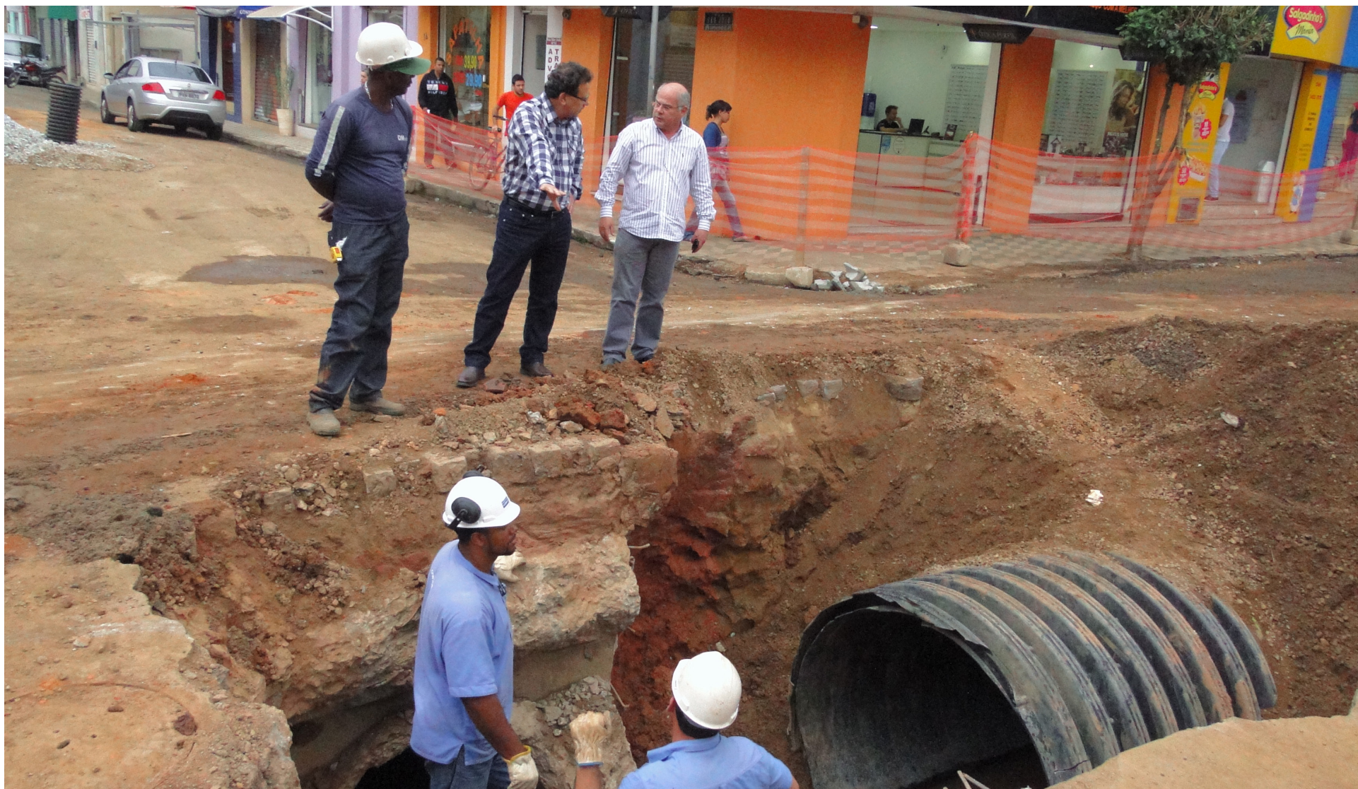
Prefeito Agnaldo Perugini e o Secretário de Obras Mauro Couto visitam a ampliação da galeria da Comendador José Garcia
